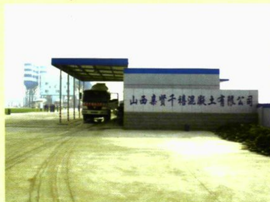
亲贤千禧混凝土有限公司
