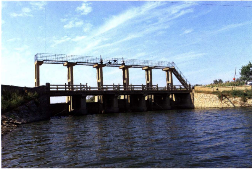
北排河献县抛庄节制闸
