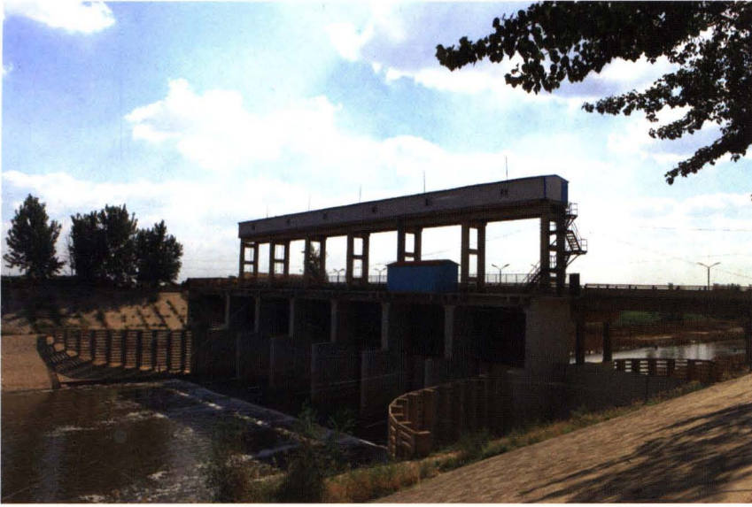
子牙河系献县枢纽进洪闸
