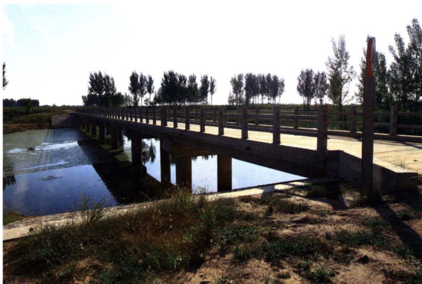
献县子牙河高坦村大桥
