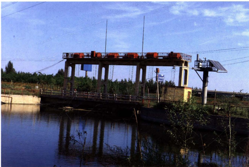
北排河献县护持寺节制闸
