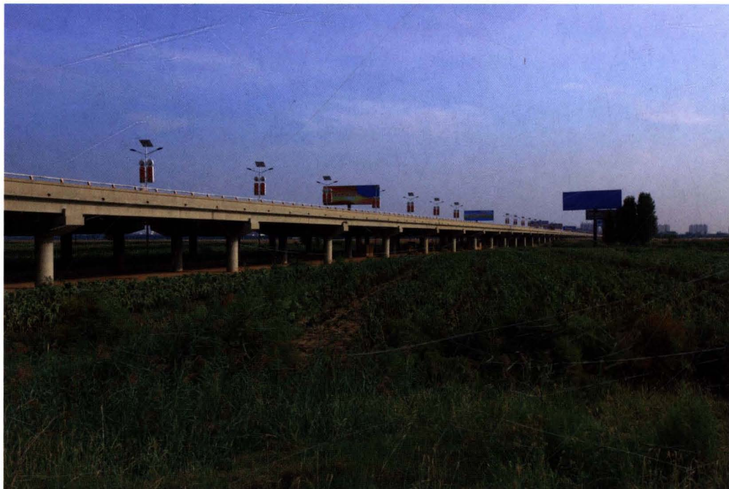
献县子牙新河滩地大桥
