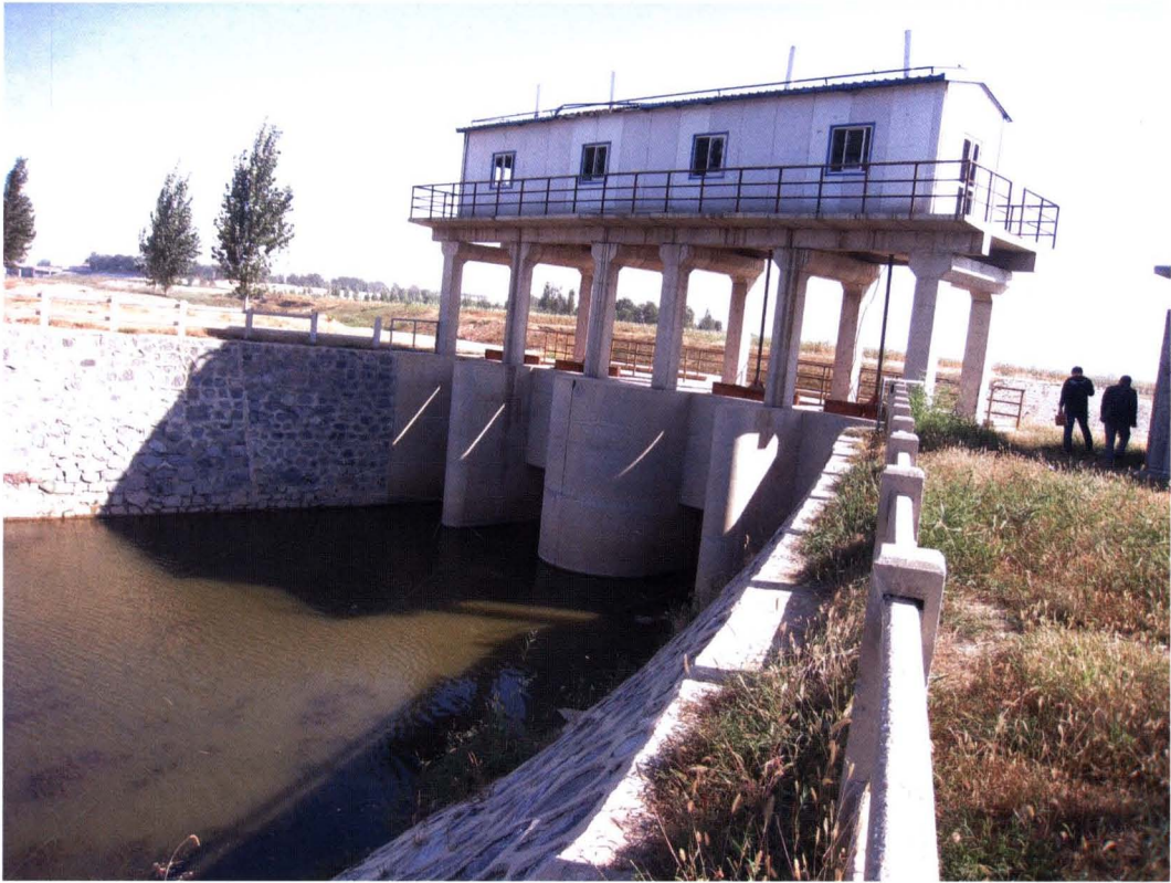
献县滏阳新河倒虹吸工程西口门
