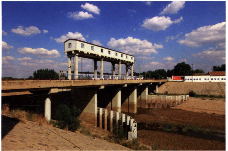
子牙河系献县枢纽节制闸
