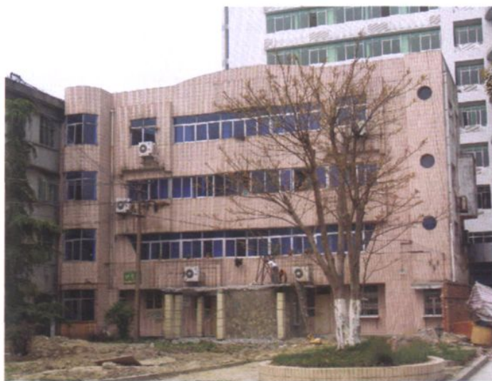
1994年~2004年医院供应室、重症监护室（ICU）及部分手术室用房
