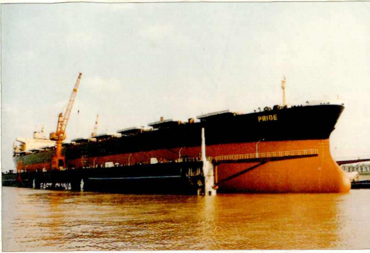
外轮在“华东”号(EAST-CHINA)浮船坞中修理
