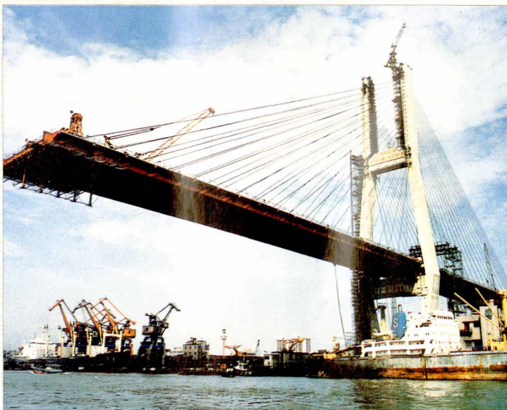
上海南浦大桥钢结构主桥在施工中
