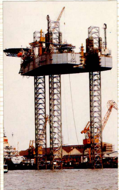
修理中的钻探平台
