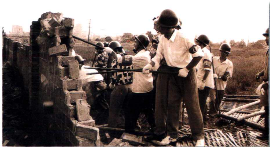
▶ 强制拆除违章建筑
