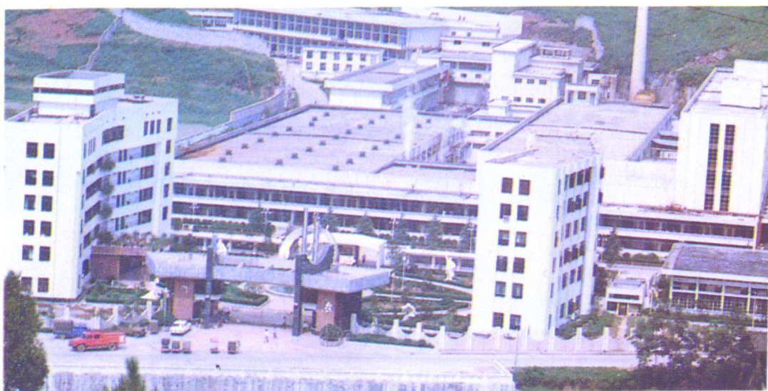
宽敞的厂区大道
