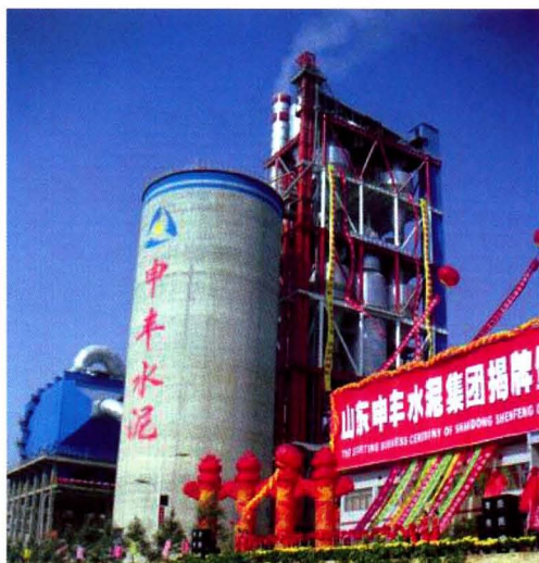
山东申丰水泥5000T/D新型干法生产线（浙江宝盛建设集团承建，2007年山东省建材工业优质工程）
