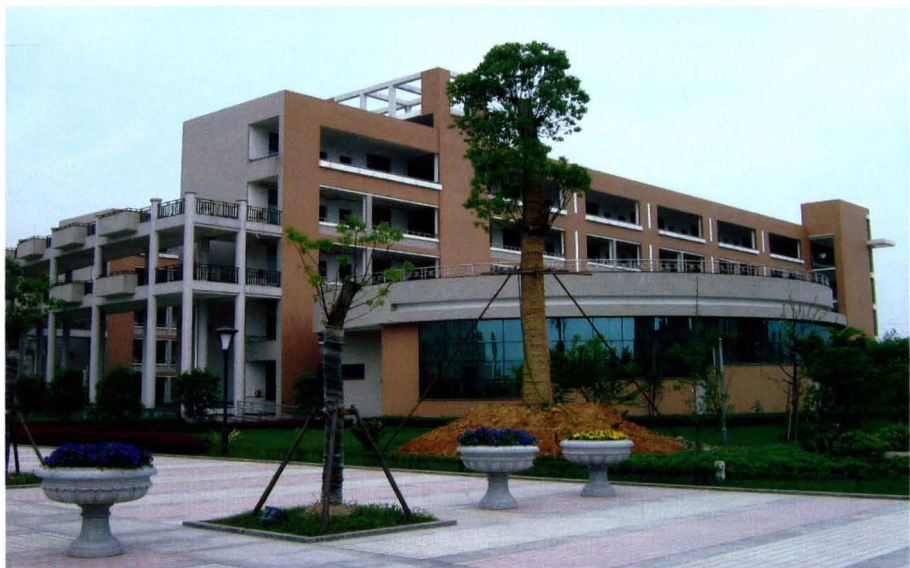
萧山第三高级中学教学楼及柱廊(杭州林森建筑工程有限公司承建,获2006年“西湖杯”奖)
