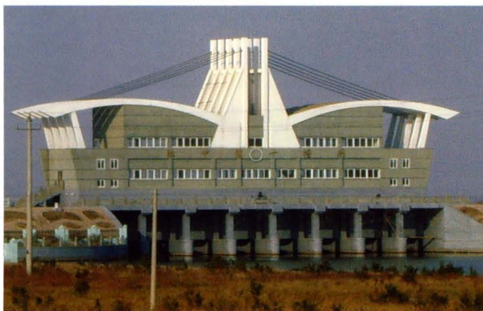
慈溪市陆中湾排涝闸（章关秀项目部建造，获2003年“甬江建设杯”奖）
