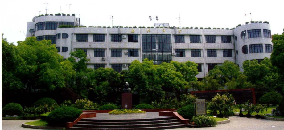
上海南洋中学（萧二建第二分公司王祥来项目部承建，获1993年度上海市“白玉兰”优质工程奖，是杭州地区进沪施工企业第一次获得上海市最高建筑奖）
