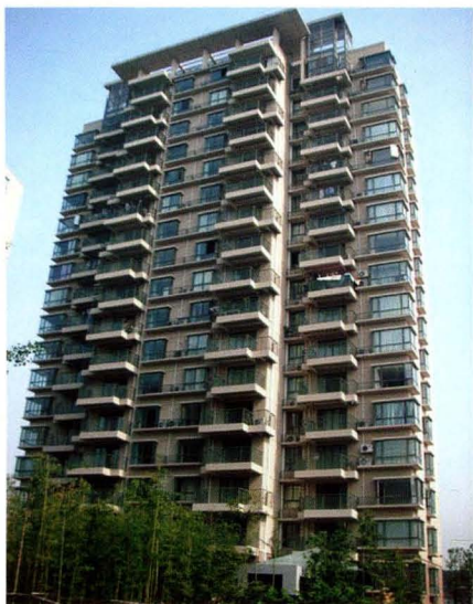
恒大小区云台路地块工程3#房（孙伟良项目部承建，上海市“白玉兰”优质工程）
