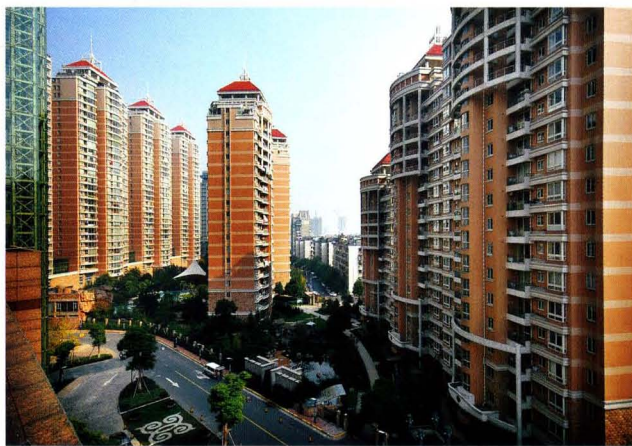
杭州开元名都住宅小区工程（浙江省一建建设集团萧山分公司王利凤项目部承建，2002年浙江省建筑安全标化工地）
