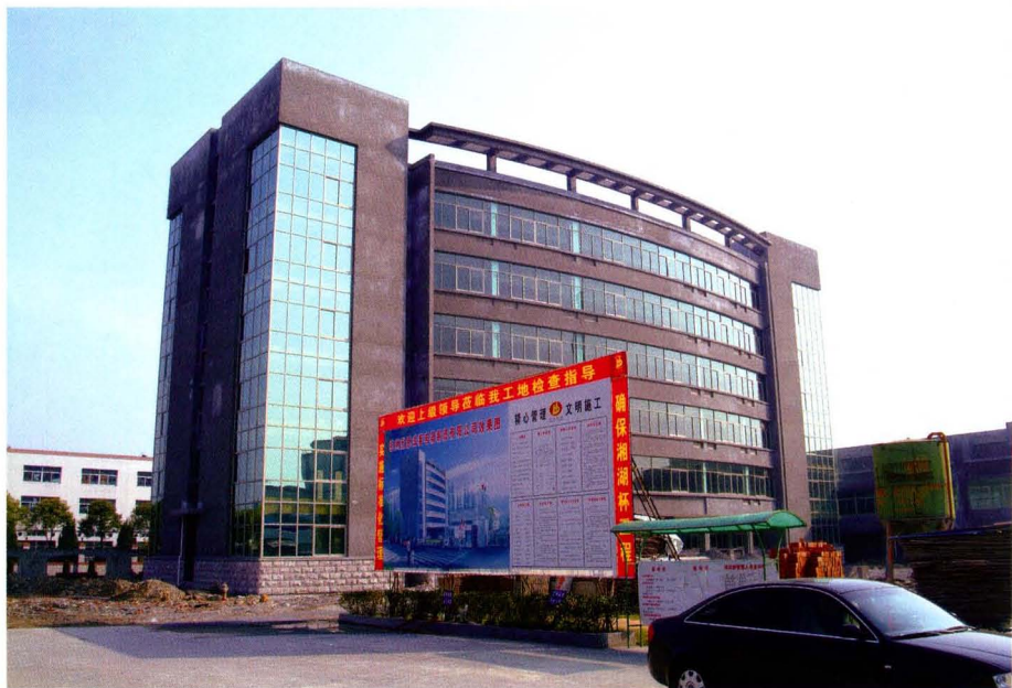
杭州欣思成套电器公司办公楼（杭州党湾建筑工程有限公司承建，获2006年“西湖杯”奖）
