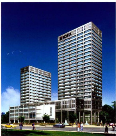
杭州瑞丰商务大厦（余传荣项目部承建，获2006年度国家优质工程银质奖）
