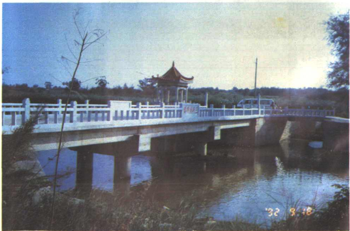
石厦三代惠济桥
