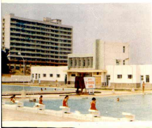
西南石油学院游泳池
