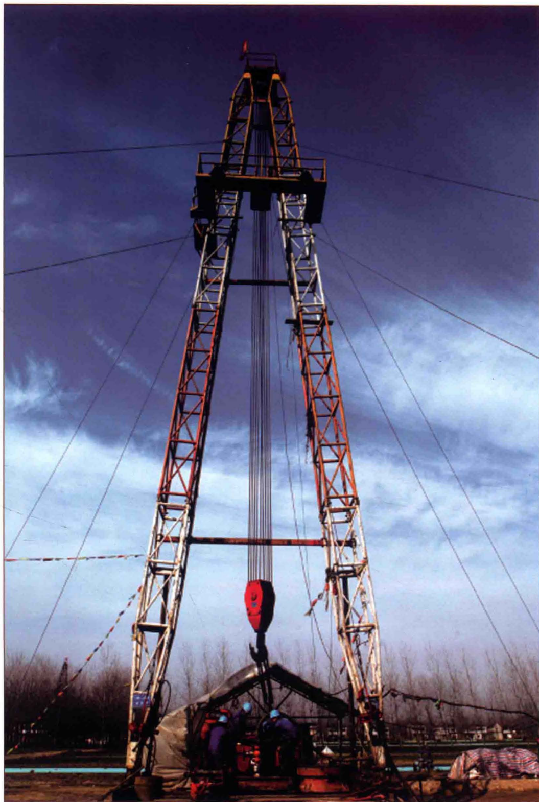
钻探作业中的 H25 井施工现场
