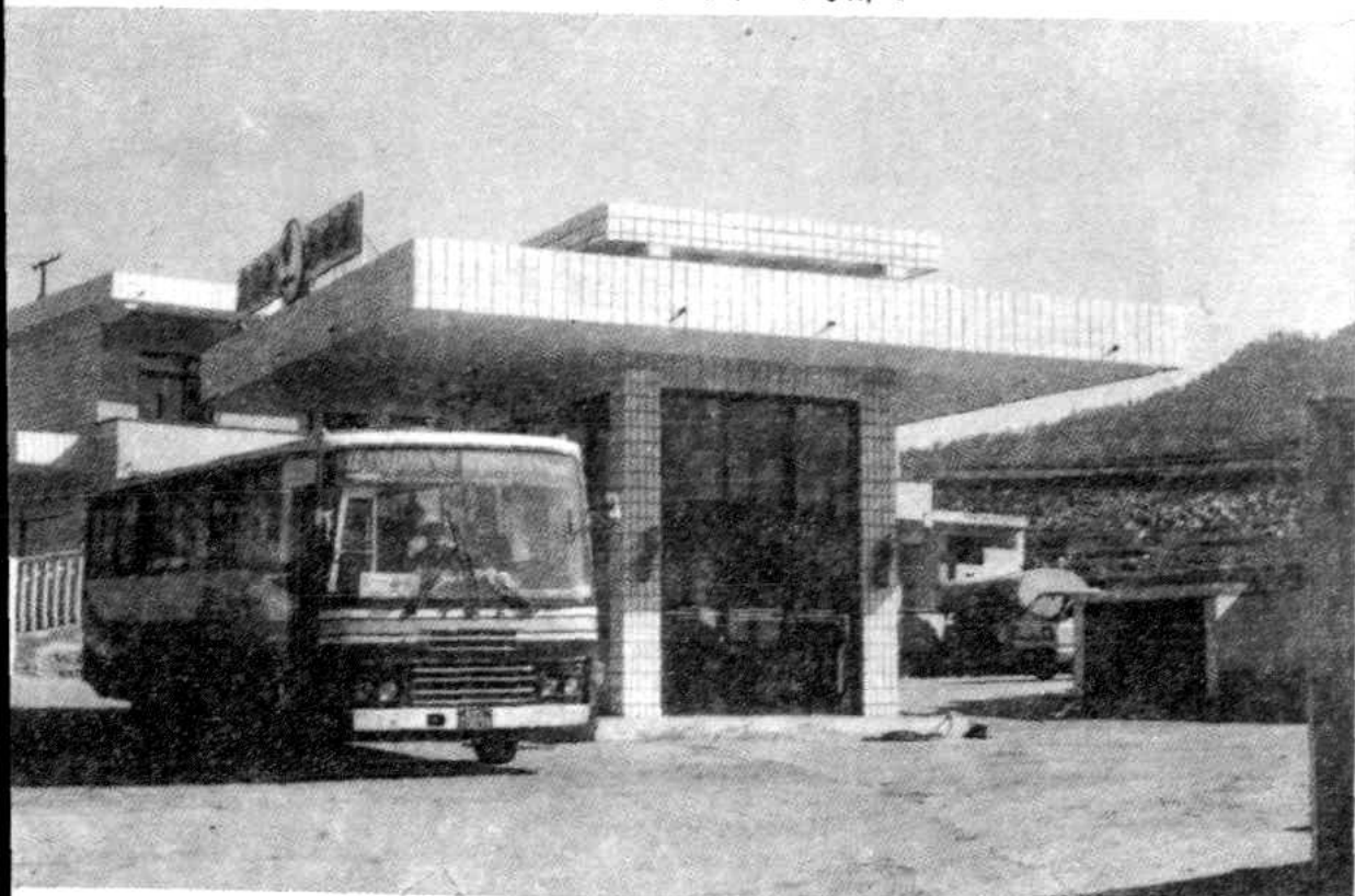
县石油公司黑神庙加油站
