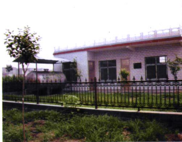
新村无塔供水
