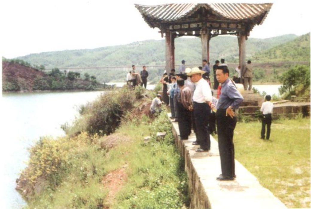
1998年6月,县政协组织有关人员视察普潮水库等县管水利设施。
