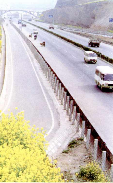
西安——三原一级公路
