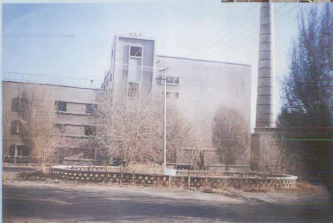
鄯善县火电厂外貌
