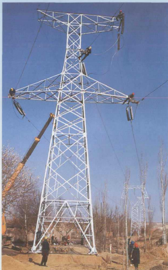
施工中的 220 千伏线路
