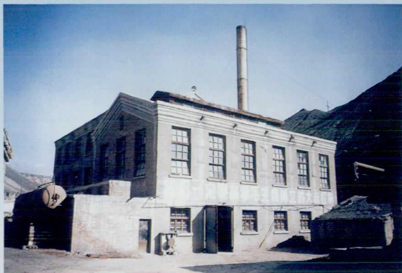
红星煤矿电厂主厂房
