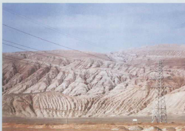
穿越火焰山的 110 千伏输电线路
