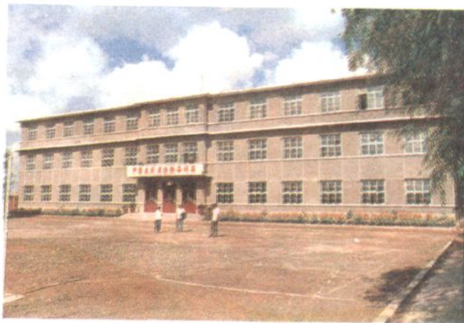
九台技工学校教学楼
