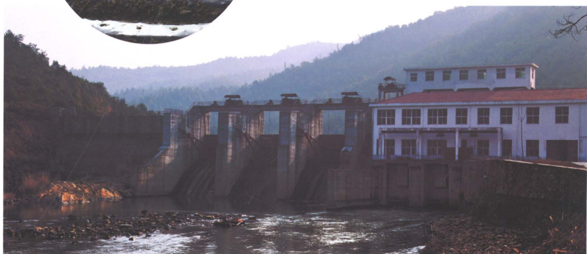
县财政局招商引资兴建的长明水电站
