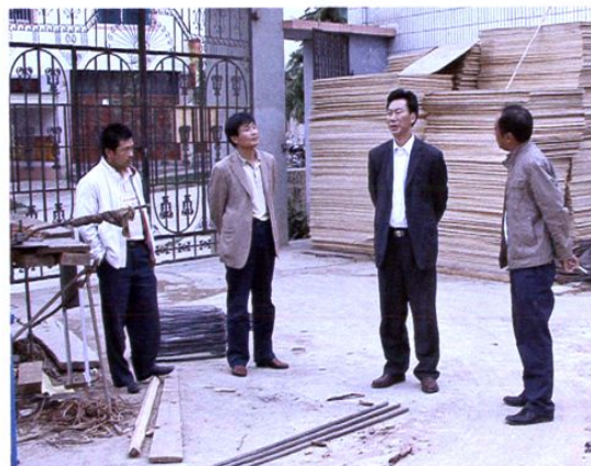
县长蔡武成（左三）视察审判大楼建设
