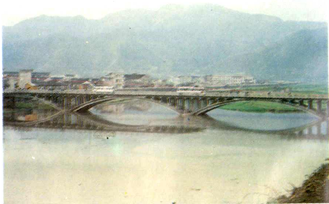
三门第一桥—海游大桥
