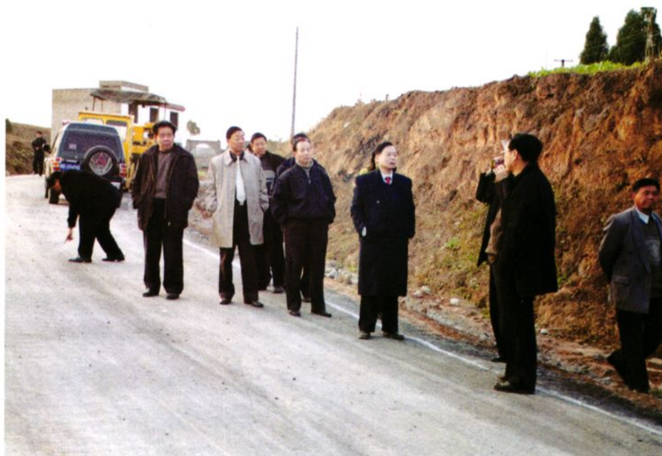
区人大常委会领导对我区环形公路建设情况进行视察
