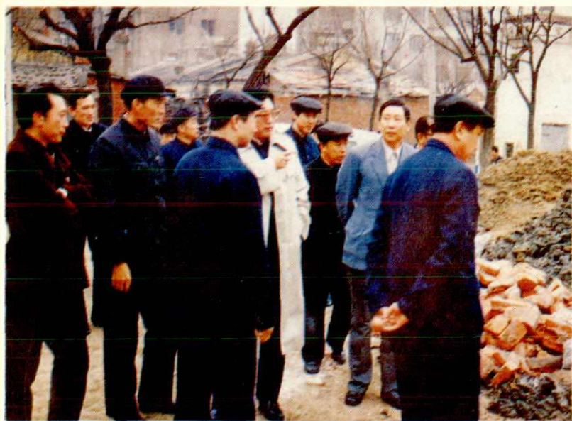
一九八五年四月，黑龙江省新华书 店新建办公大楼动工，省委副书记陈云 林（中，着白色风衣者）同省出版社 领导班子成员一起视察工地
