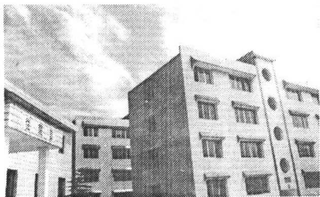
车岭卫生院住院部及职工宿舍楼
