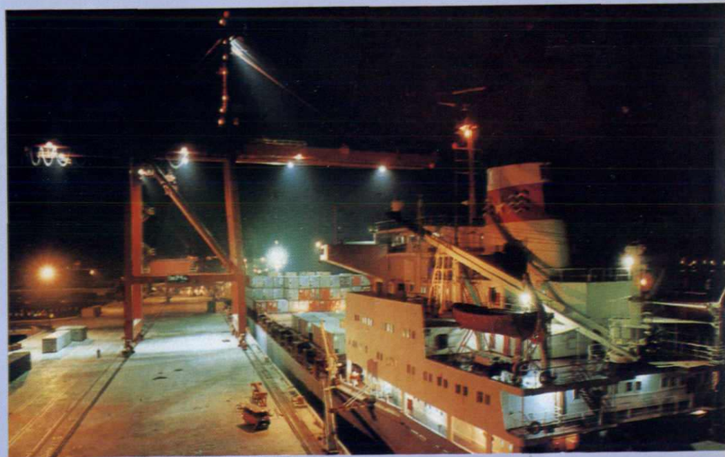
宁波港北仑港区集装箱码头
