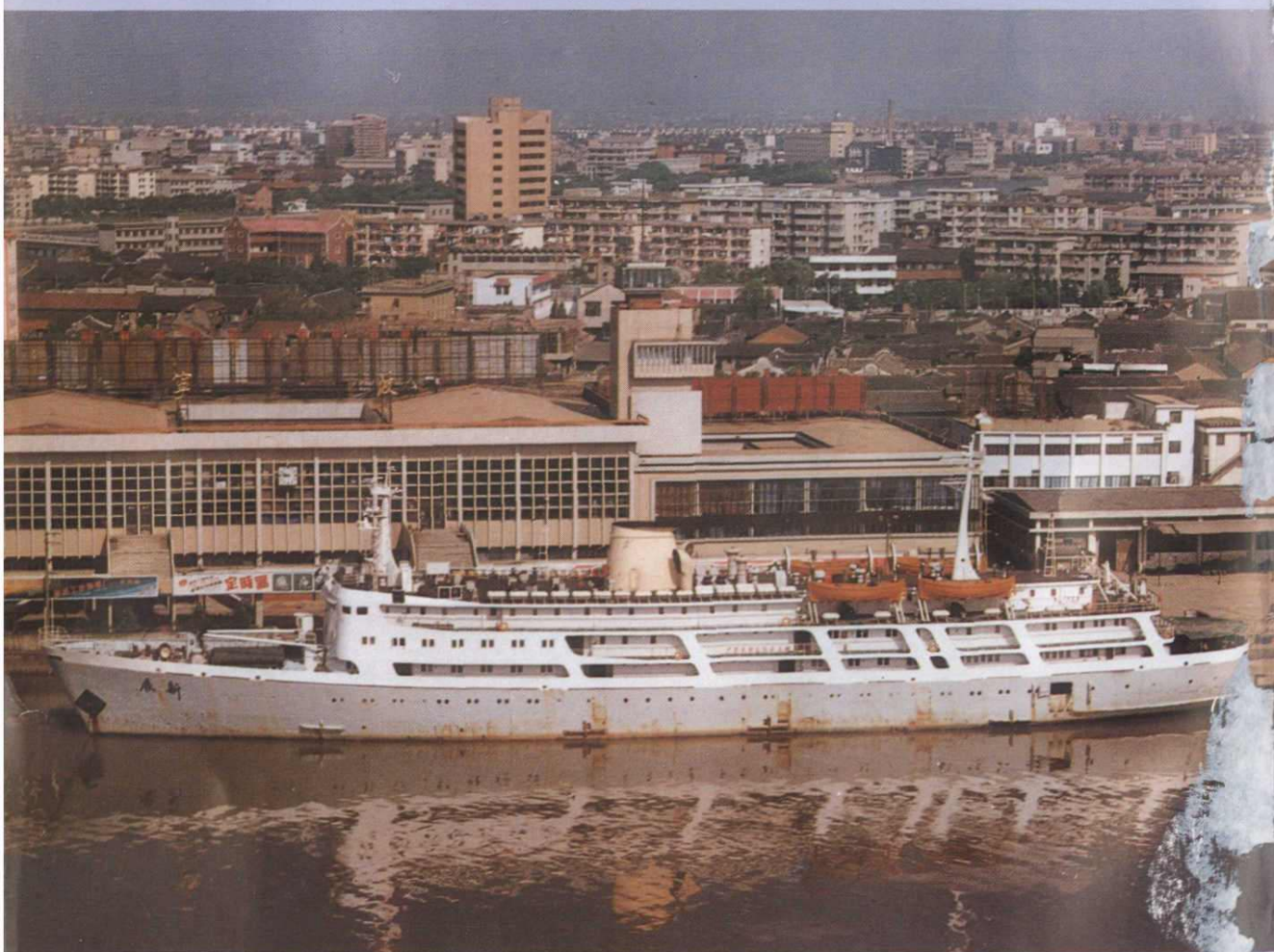
宁波港港区客运码头
