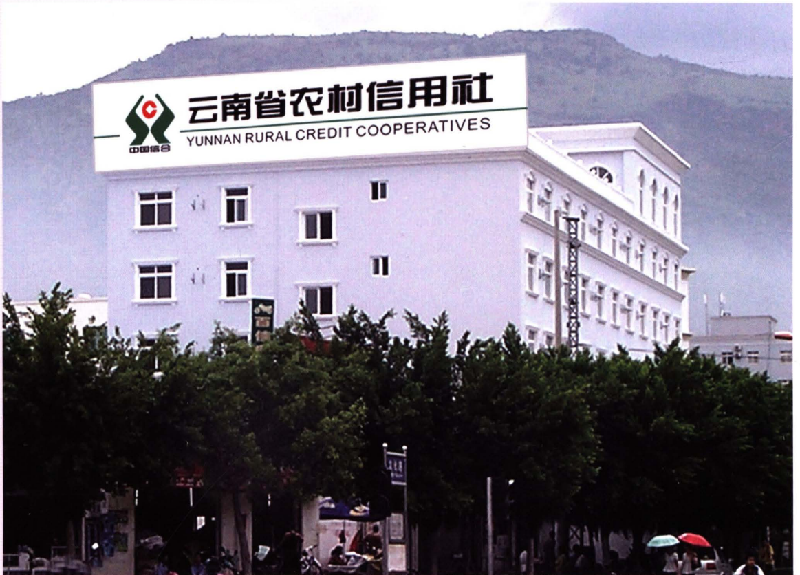
元江县农村信用合作联社综合办公大楼外景
