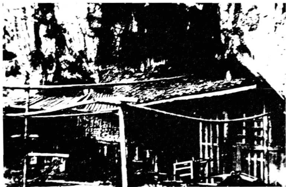
1938年桂 林电力分厂雒 山发电厂岩洞 机房一角（市 档案馆提供）
