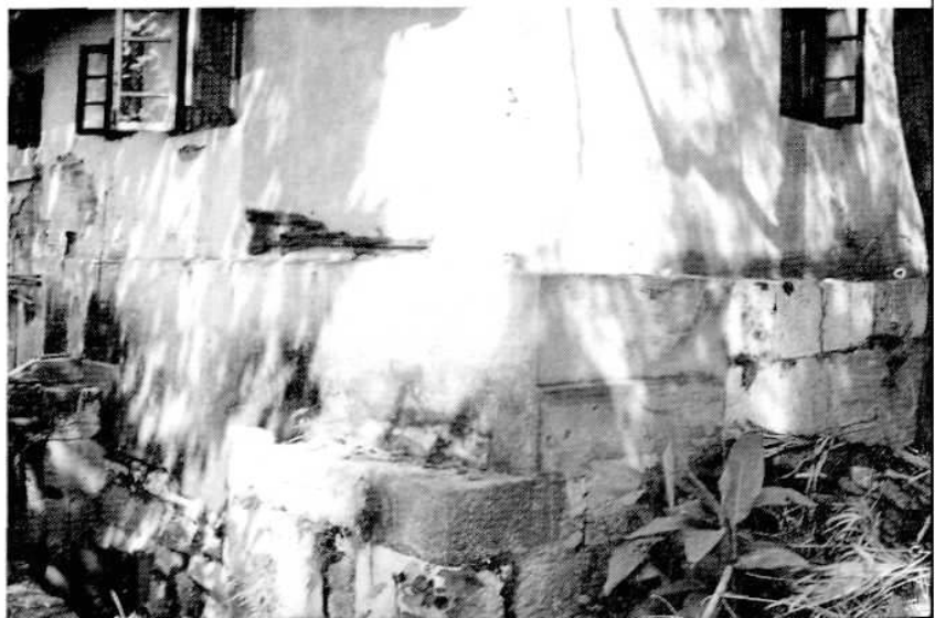
1948年建成投 产的阳江水力发 电示范厂机房进 水口
