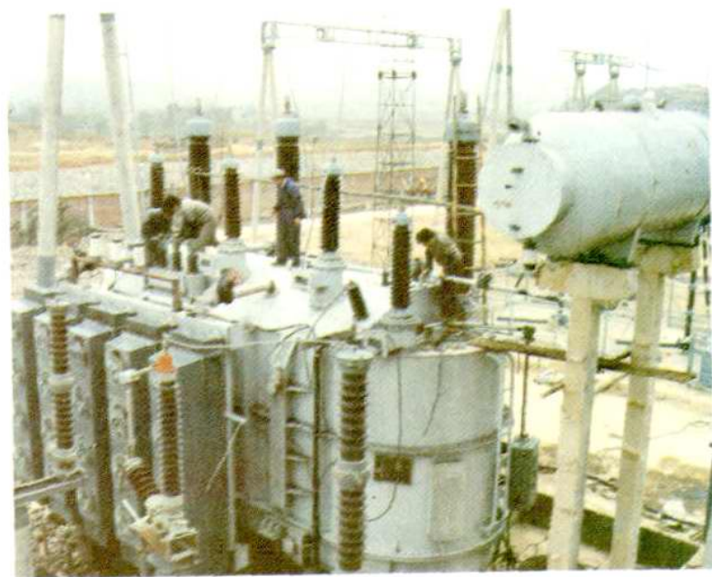
220千伏巖村变电站二期工 程在安装主变容量9万千伏安
