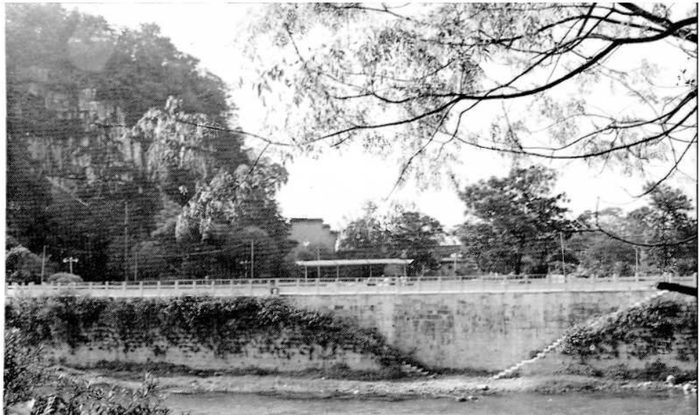
1916年创 办的桂林电灯 公司象鼻山发 电厂船岸遗址
