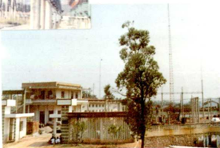
110千伏荔浦县变 电站容量2万 千伏安
