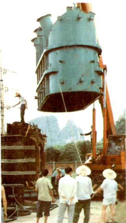
左图 修试车间 工人对北门变电站主 变进行吊芯检查
