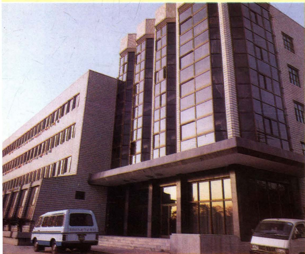
公司科技档案楼
