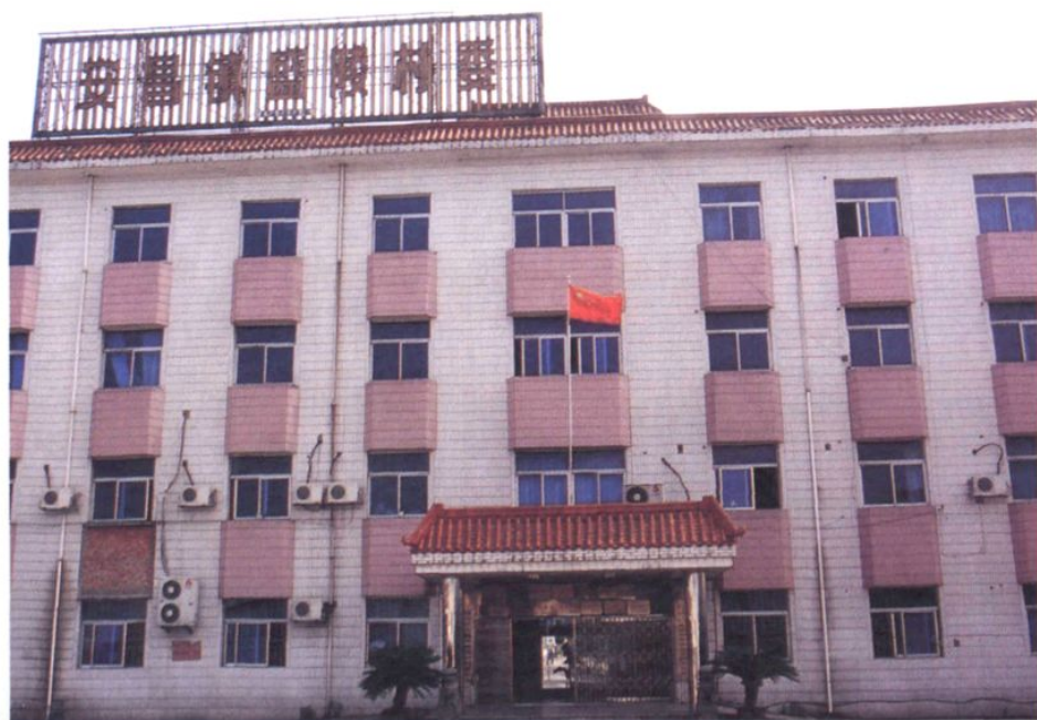
村委办公大楼
