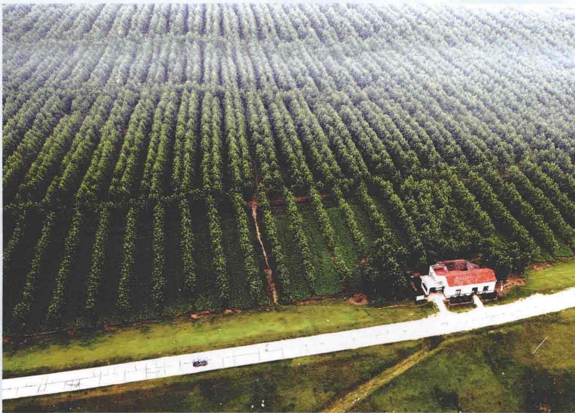
防护林、管养用房
