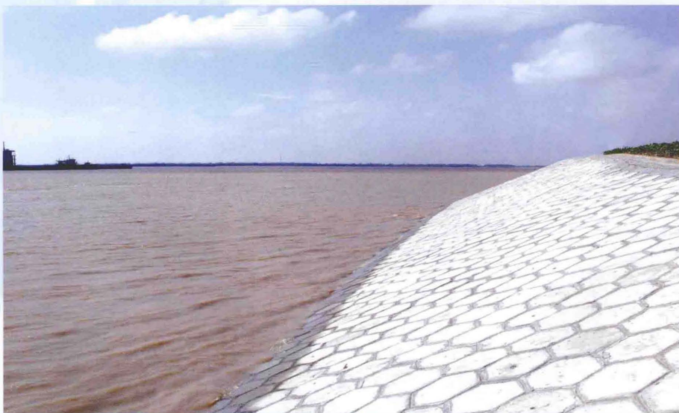
堤防护岸工程
