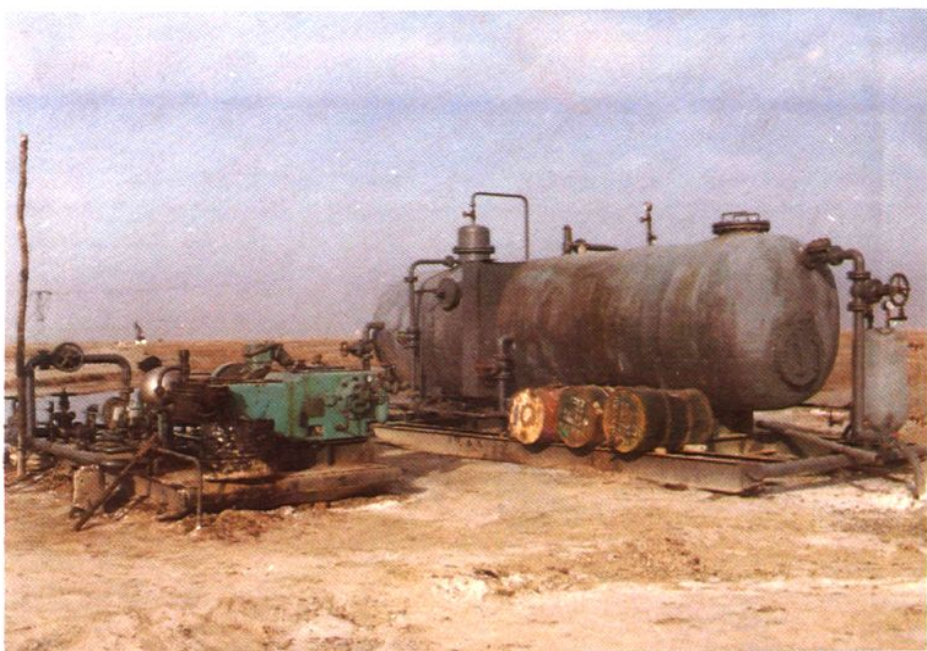
⑥ 第一口单体泵井试验
