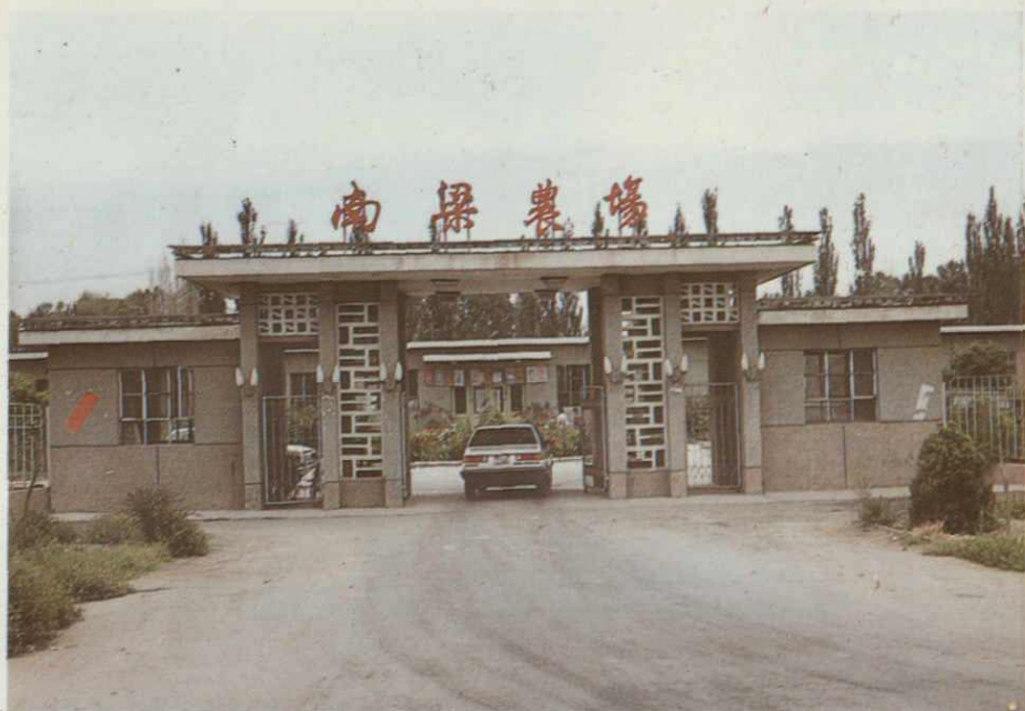
南梁农场场部
