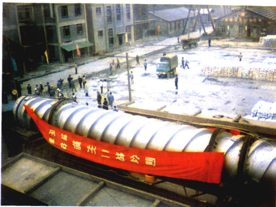
福州耀隆工贸总公司4万吨/年联碱工程关键设备 \phi 2000x20000mm煅烧炉生产装置
