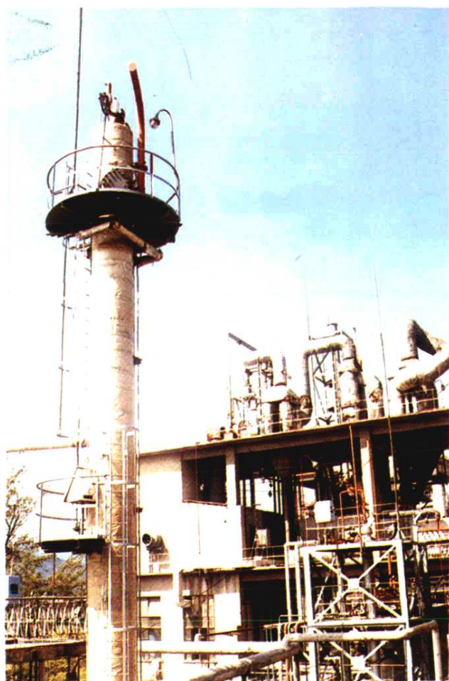
福州第二化工厂聚氯乙炔车间一角
