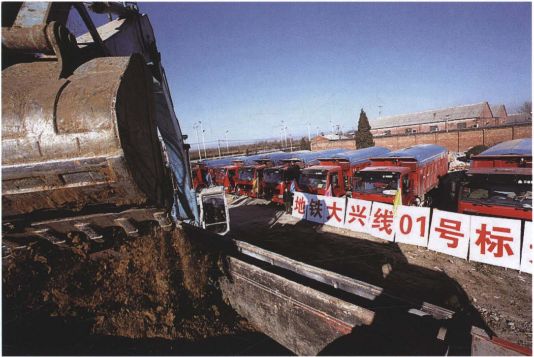
地铁大兴线01号标段
