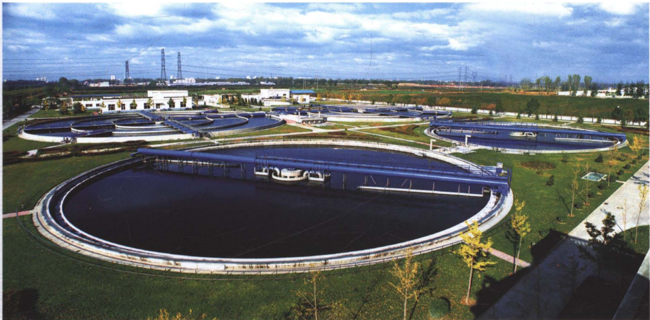
大兴污水处理场—为产业基地基础设施“九通一平”做保障
