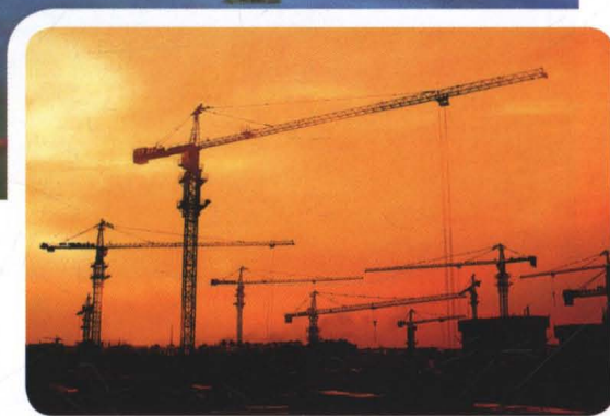
建设中的新城
