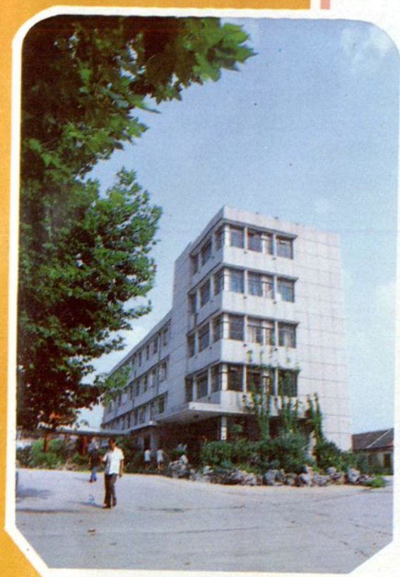
石油站办公大楼
