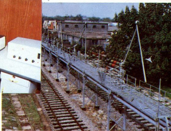
蚌埠石油站铁路专用线和栈桥
