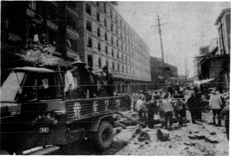
一九八四年正在改造中的人民路施工现场
