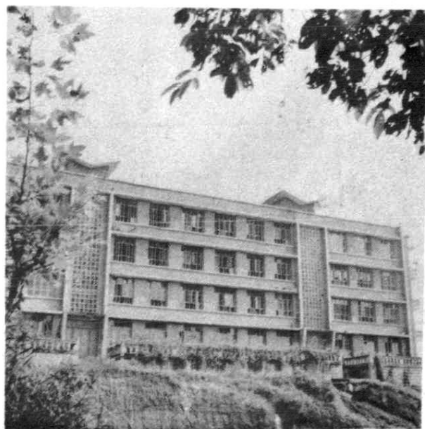
一九七九年由二建司施工的师专综合教学楼
