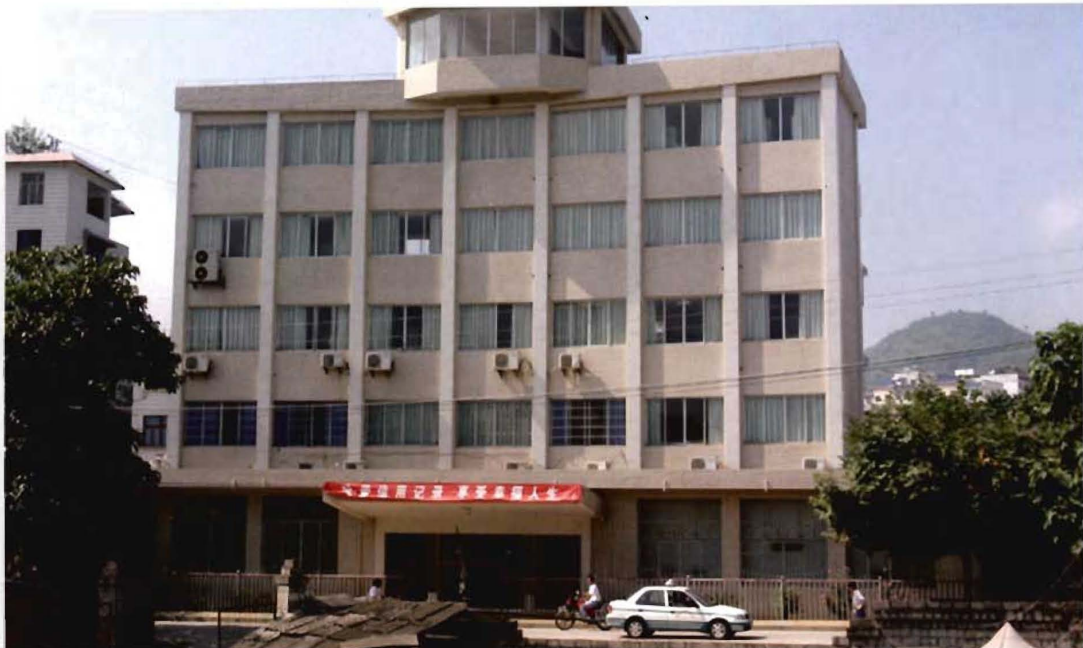
■正安县人民银行办公大楼（摄于2007年）
