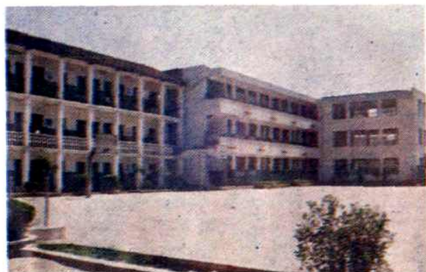
人民路小学教学楼
