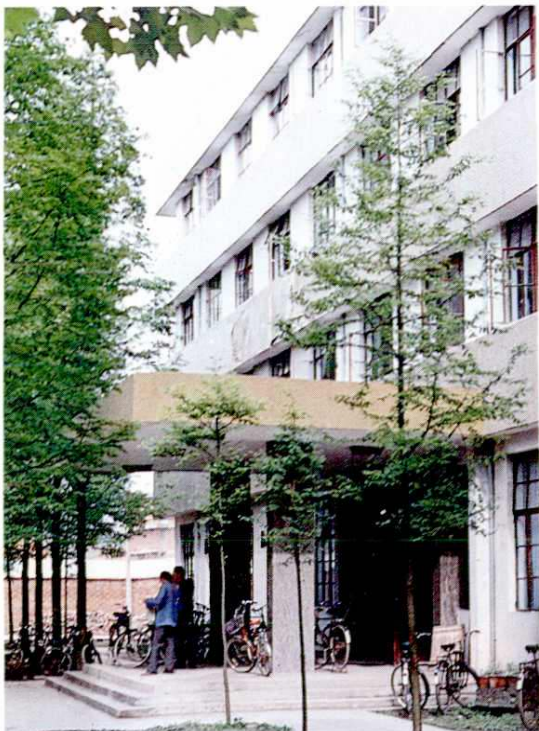
中共永康县委办公大楼
