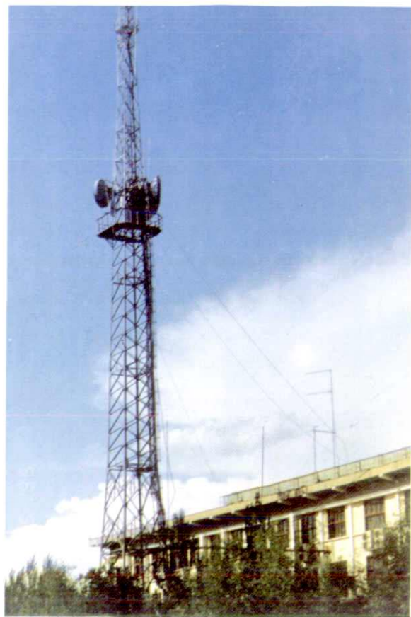
伊犁州局微波塔
