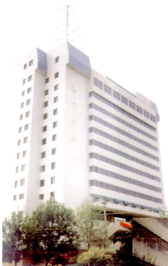
新建的解放路通信大厦
