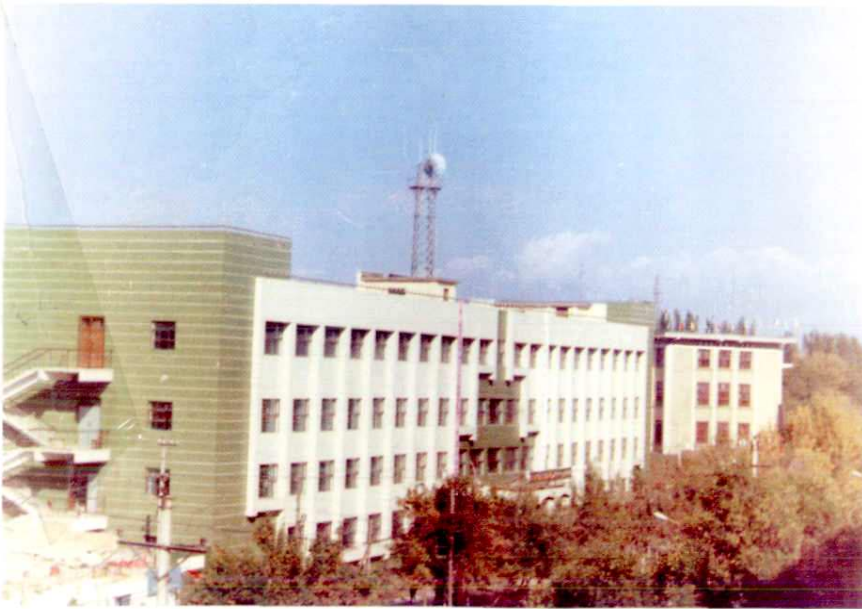
伊犁哈萨克自治州邮电局邮政大楼
