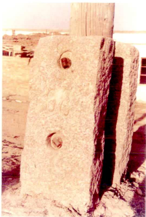
沙俄在伊犁架电报线路所遗石头帮桩
