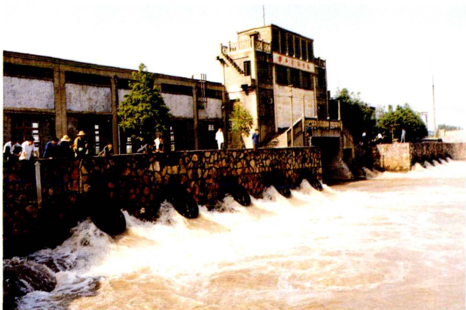
湖州市郊郭西湾电力排涝站 郑秦庄摄
