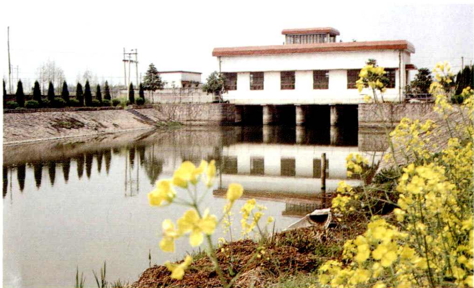
德清县城南电力排涝站
