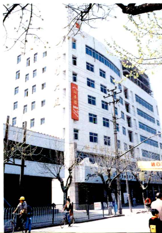
新建的综合大楼——水利大厦
