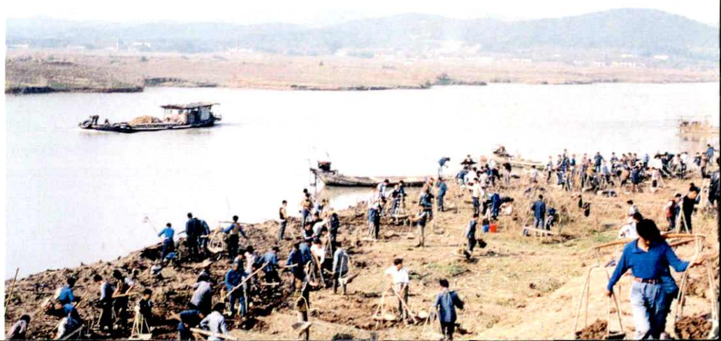
东苕溪导流东大堤培修加固 李忠元摄
