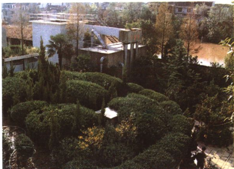
自来水厂蓄水池
