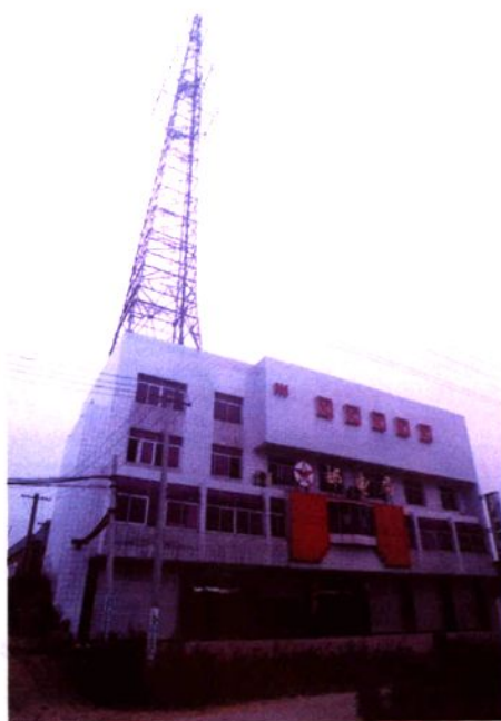
1997年竣工的罗江县鄢家邮电支局
