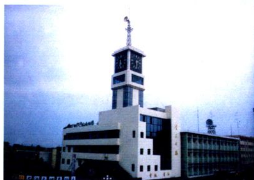
1991年9月竣工的什邡市电信大楼
