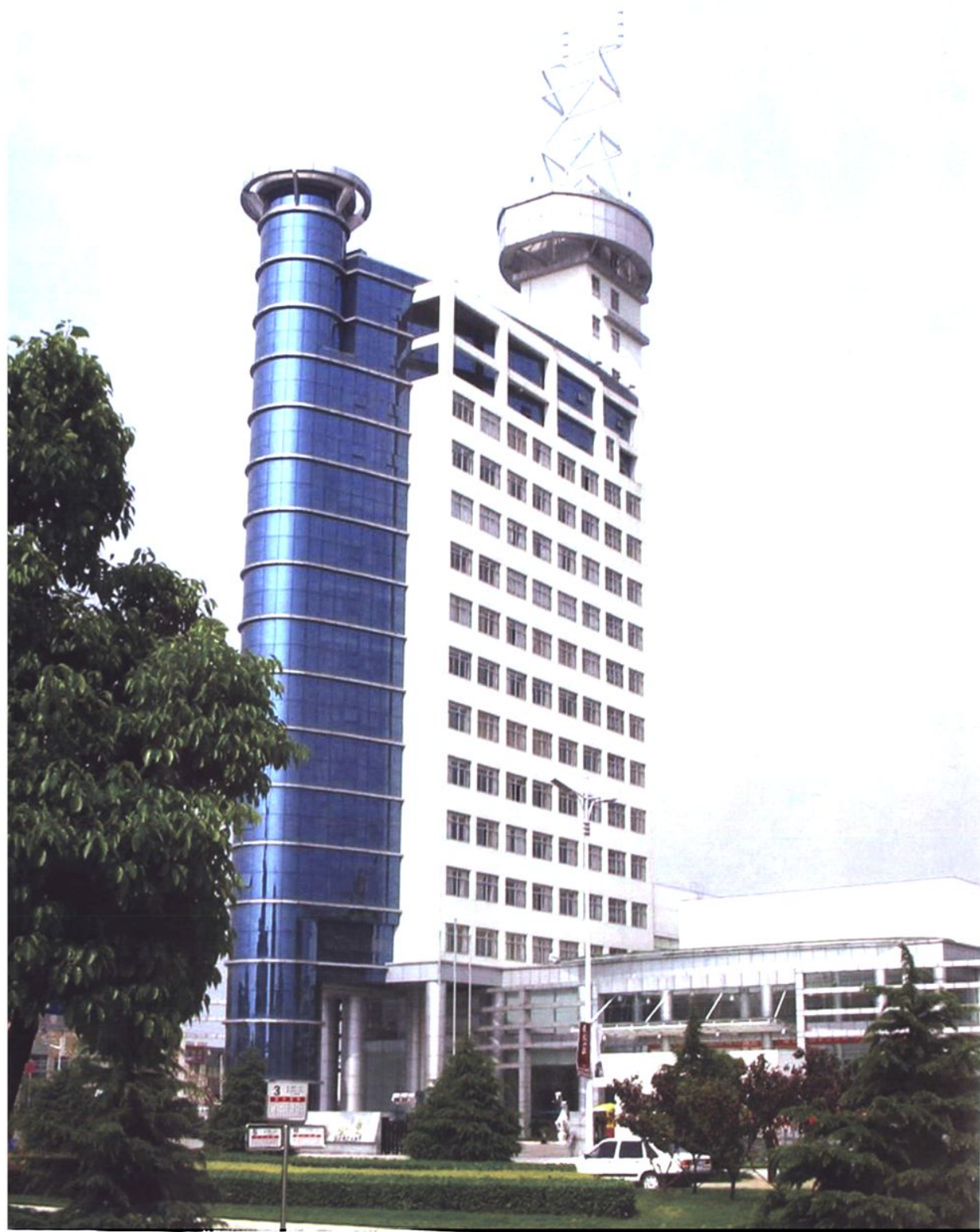
溧阳市供电公司生产调度大楼(摄于2004年4月28日)
