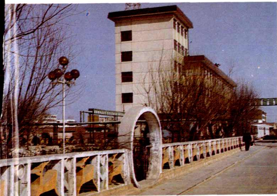
院科研试验楼
