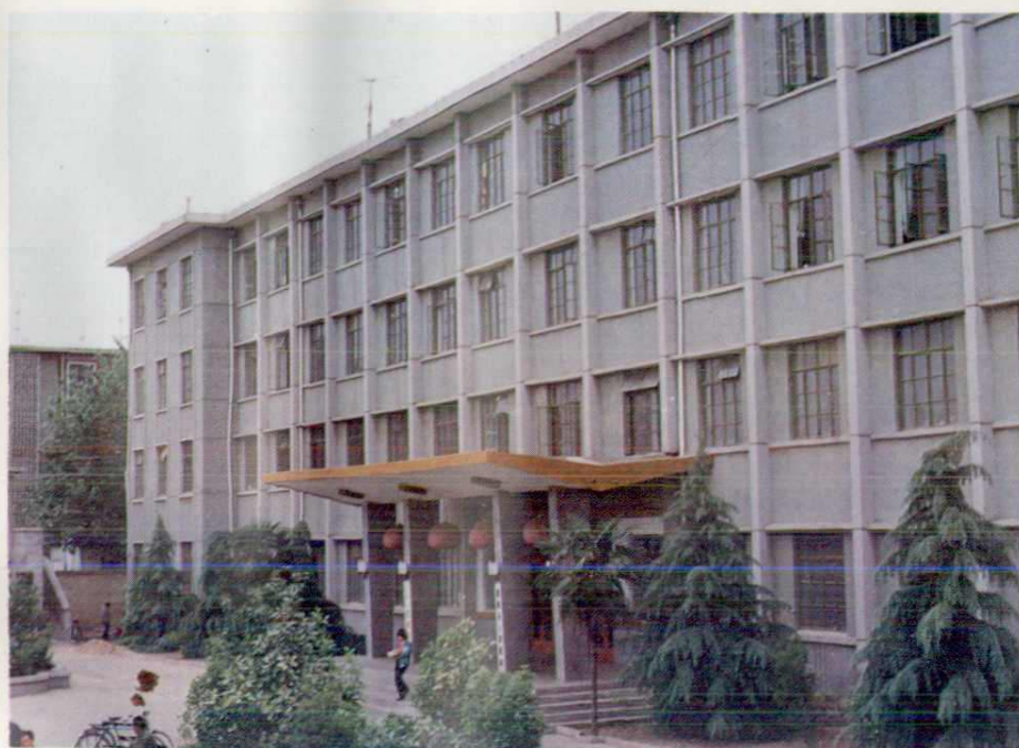
县人民政府办公楼
