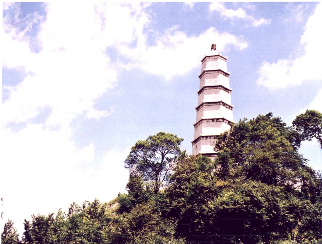
清咸丰元年(1851年)重修的西秀山石塔
