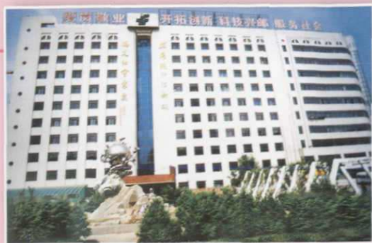
1995年投入使用的乌鲁木齐市邮政局办公大楼
