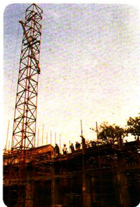
镇建筑公司承建的县工业局六层大楼施工工地
