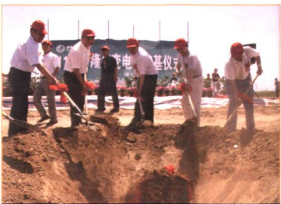
▲ 2007年5月、110千伏隆化变电站奠基
