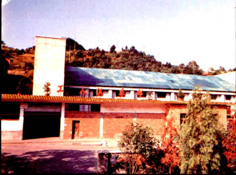
正在建设中的新岭煤矿工人俱乐部
