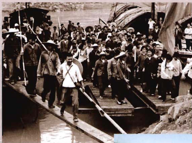
1974年，建设大军开进云天化厂建设工地
